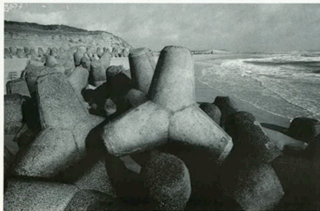
Die Tetrapoden, riesige Vierfüßer aus Beton, haben nicht gehalten, was sich die Ingenieure von ihnen versprochen. Statt die Gewalt der Wellen zu brechen, beschleunigten sie teilweise das Ausspülen des Strandes
